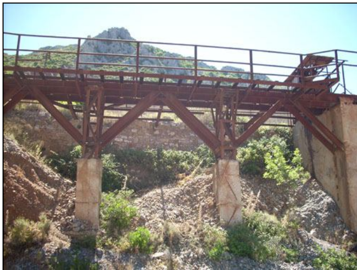
Tracciato ferroviario presso Acquaresi.
