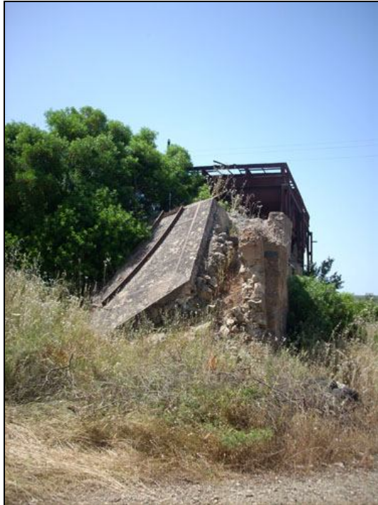
Cantiere Ilario – Binari sopraelevati per il carico nelle tramogge.
