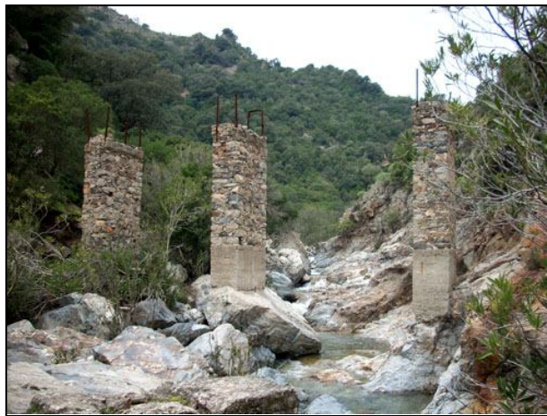
I piloni del tracciato ferroviario sopraelevato.
