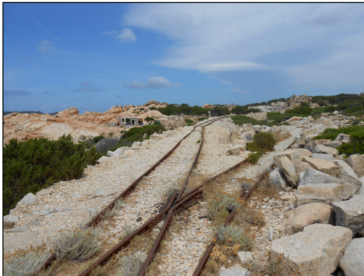
Binari e scambi dell'antica decauville della Cava.
