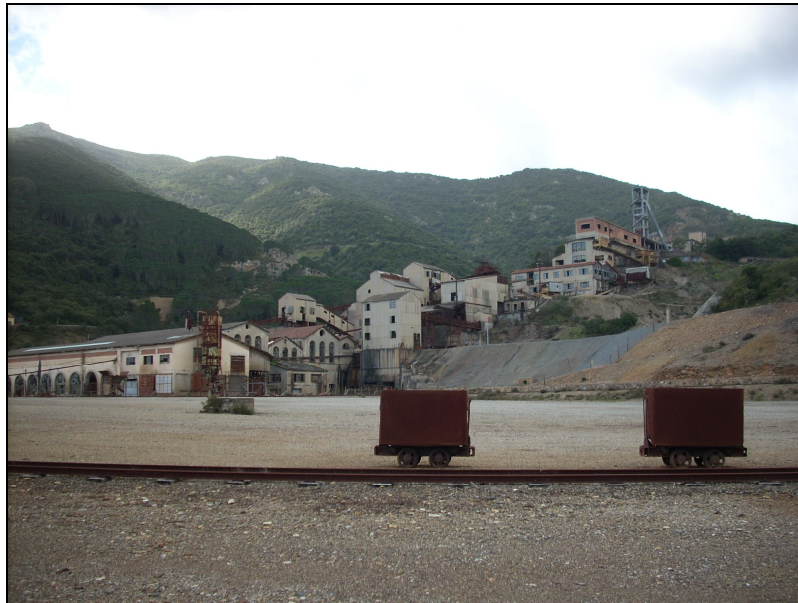
Vagoni nel cantiere Piccalinna (Montevecchio Levante).
