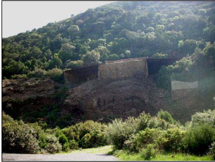
Tracciato ferroviario della miniera.
