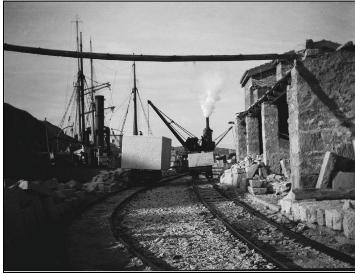
Decauville sul molo per il carico dei blocchi di granito sul mercantile.
