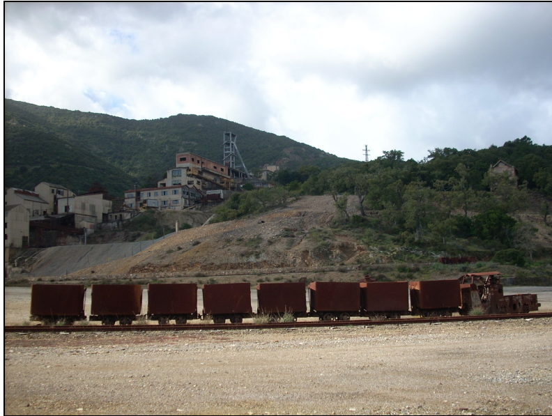
Vagoni nel cantiere Piccalinna (Montevecchio Levante).
